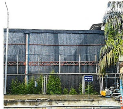
ภาพที่ 2.2-16 ถังพักน้ำทิ้งฉุกเฉินขนาด 50 ลูกบาศก์เมตร
