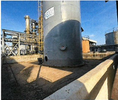
ภาพที่ 2.2-20 คันคอนกรีตกั้นน้ำบริเวณลานถังเก็บก๊าซสารเคมี
