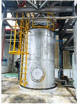
ภาพที่ 2.2-17 ถังพักน้ำทิ้งฉุกเฉินขนาด 10 ลูกบาศก์เมตร
