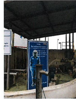
ภาพที่ 2.2-20 คันคอนกรีตกั้นน้ำบริเวณลานถังเก็บก๊าซสารเคมี
