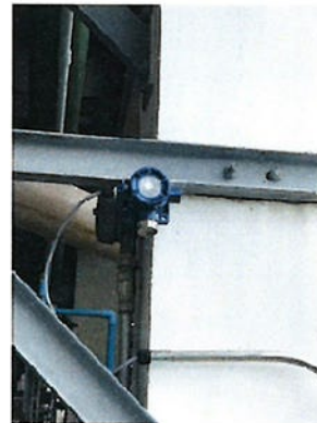
ภาพที่ 2.2-47 เครื่องตรวจวัดความเป็นพิษของสารเคมี (Toxic Gas Detector)
