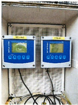
ภาพที่ 2.2-23 อุปกรณ์ตรวจวัดค่าความนำไฟฟ้าแบบอัตโนมัติ
