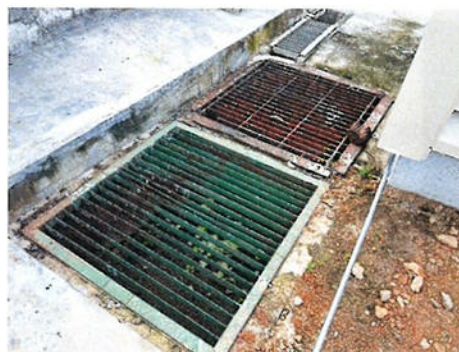
ภาพที่ 2.2-26 บ่อดักน้ำมันเพื่อรองรับน้ำและน้ำมันดีเซลรั่วไหล
