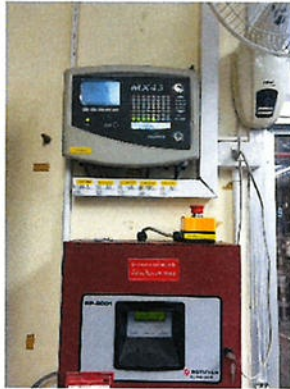
ภาพที่ 2.2-47 เครื่องตรวจวัดความเป็นพิษของสารเคมี (Toxic Gas Detector)
