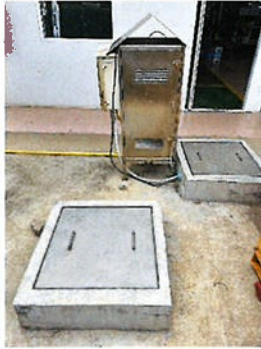
ภาพที่ 2.2-10 ถังบำบัดน้ำเสียสำเร็จรูปแบบเติมอากาศ
