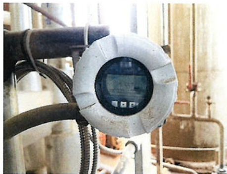
ภาพที่ 2.2-56 เครื่องตรวจวัดความดันที่ท่อขนส่งสารเคมี
