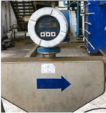
ภาพที่ 2.2-51 อุปกรณ์ตรวจวัดปริมาณหรืออัตราการไหลของเมทานอล อากาศ และน้ำ
