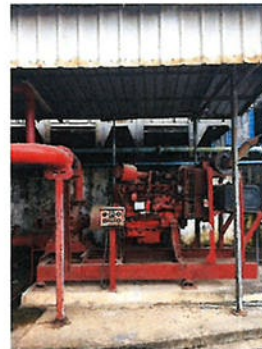
ภาพที่ 2.2-58 เครื่องสูบน้ำดับเพลิงและถังเก็บน้ำสำรองดับเพลิง
