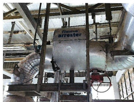
ภาพที่ 2.2-50 Flame arrester
