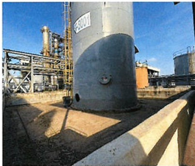
ภาพที่ 2.2-13 ถังพักน้ำเสียขนาด 120 ลูกบาศก์เมตร
