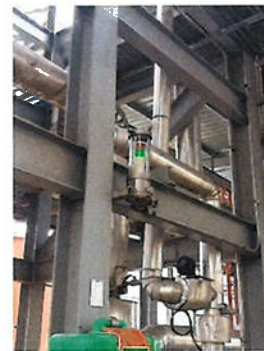
ภาพที่ 2.2-5 เครื่องตรวจวัดการรั่วของฟอร์มัลดีไฮด์แบบต่อเนื่อง (Gas Detector)
