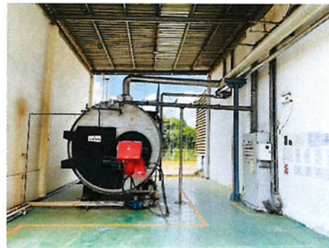
ภาพที่ 2.2-1 หม้อไอน้ำสำเร็จรูป Package Boiler
