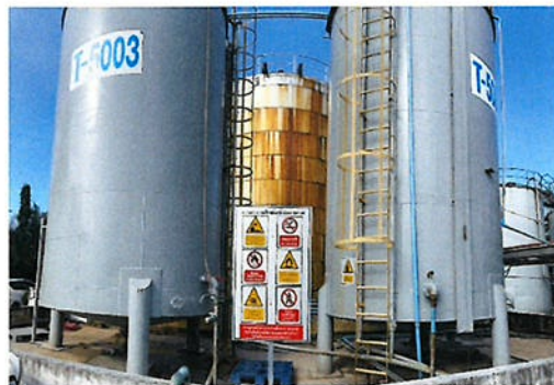
ภาพที่ 2.2-21 ถังพักน้ำเสียขนาด 90 ลูกบาศก์เมตร
