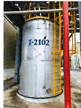
ภาพที่ 2.2-17 ถังพักน้ำทิ้งฉุกเฉินขนาด 10 ลูกบาศก์เมตร
